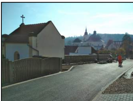
Oprava cesty nad hřbitovem
