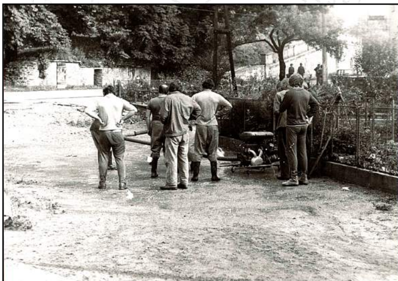
Čištění obecní studny pod kostelem po opadnutí vody. Kulminovala až na silnici.
